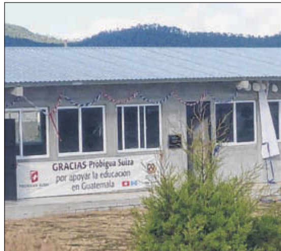
Das neue Schulhaus im Hogar Nuestra Señora de los Remedios in Jalapa.
